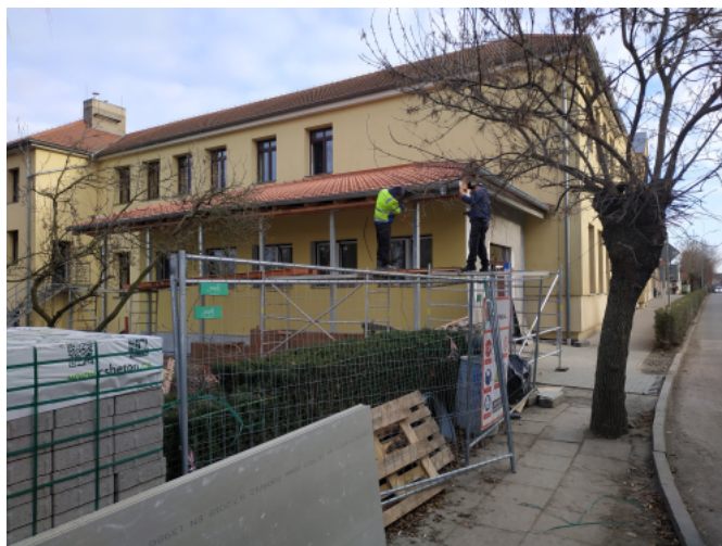
Foto: venkovní přístavba - nové šatny
