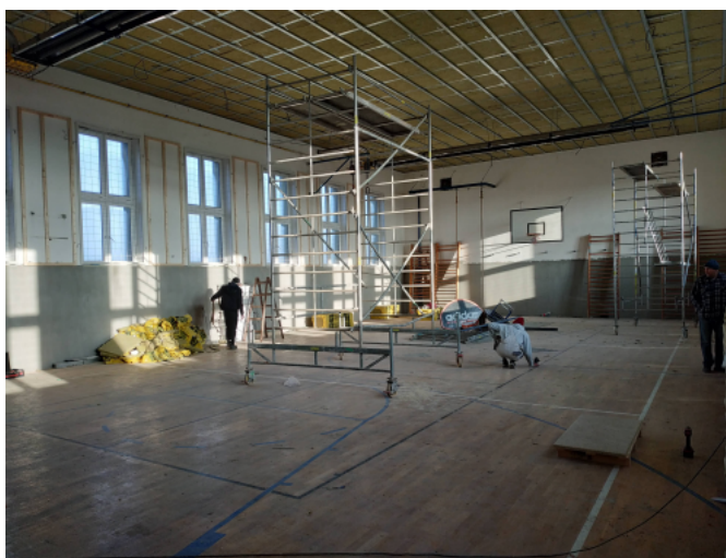
Foto: rekonstrukce tělocvičny
