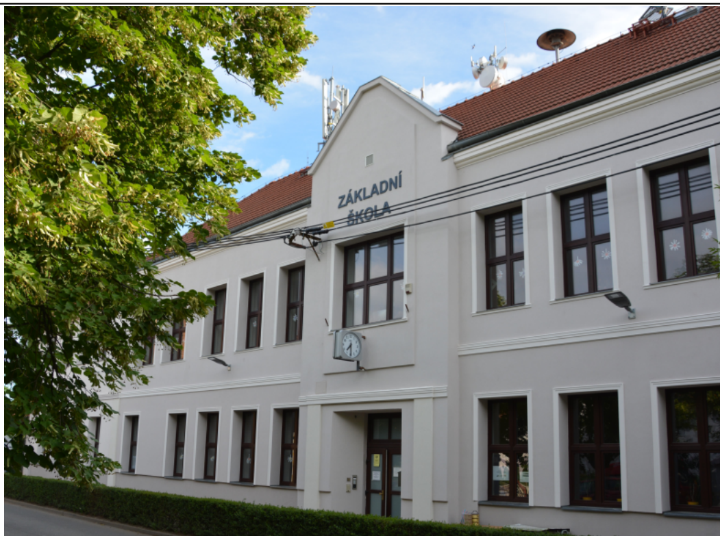
Opravená budova ZŠ Semice
