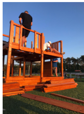
Stavba dětského hřiště na fotbalovém hřišti
