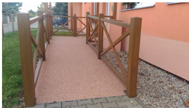
Úprava vchodu do MŠ
