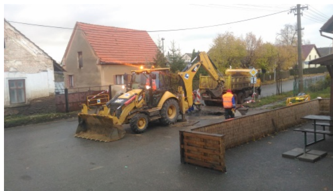
Budování obecního vodovodu
