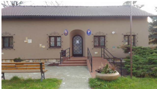
Bezbariérový přístup na OÚ a úprava okolí budovy
